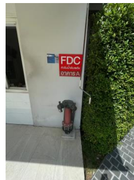
หัวรับน้ำดับเพลิงอาคาร A และอาคาร B
