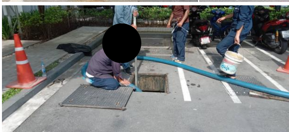
รูปที่ 2-41 สืบสิ่งปฏิกูลและดูดไขมัน เมื่อวันที่ 21 กันยายน 2565
