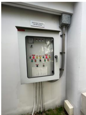
รูปที่ 2-12 ตู้ควบคุมระบบบำบัดน้ำเสีย
